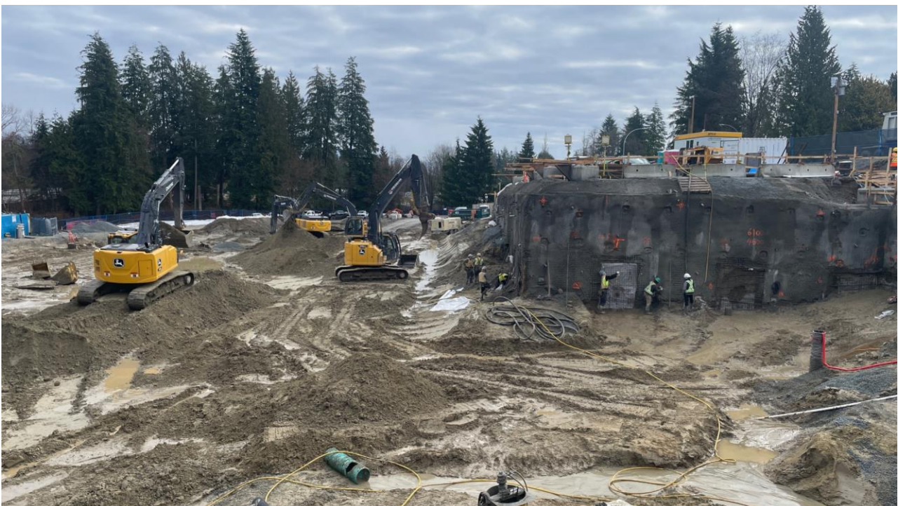
Foto de obra, tomada el 23 de Febrero de 2024.
